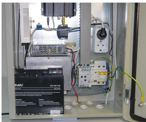
Рисунок 16. Установка аккумулятора в монтажный щит.
