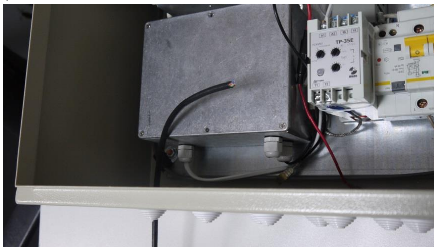
Рисунок 10. Заведение кабеля локальной сети в монтажный щит.
