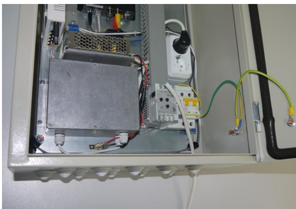
Рисунок 13. Заведение кабеля питания в монтажный щит.
