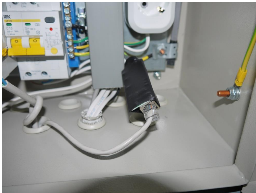
Рисунок 12. Кабель локальной сети, подключенный к грозозащите.
