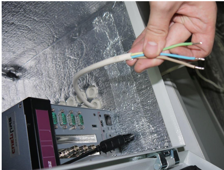
Рисунок 6. Подготовка кабеля питания к подключению.
